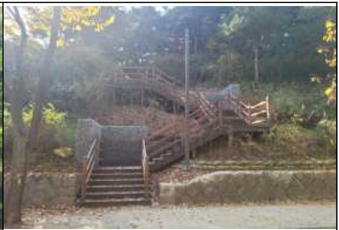
진입로 계단 공사 준공 후
