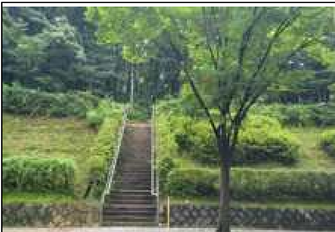
진입로 계단 공사 착공 전
