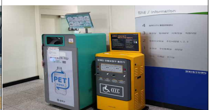
전동보장구 급속충전기 설치 (잠실2동)
